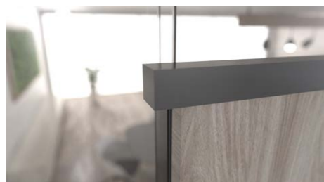
Detail řešení v místě spojení posuvného systému plných dveří a nadsvětlíku
